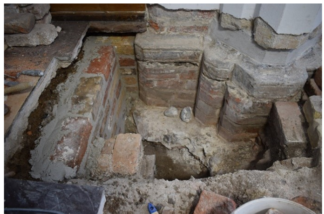
Fig. 16. Schakt B och C. Fundament till lisener i koromgångens östra vägg samt sockel till västligaste valvpelaren i kyrkans sydsida. Det är här som en bindbjälke på kyrkvinden daterats 1384. Foto: Anders Reisnert.
