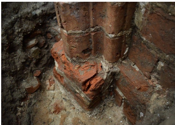
Fig. 16. Schakt B och C. Fundament till lisener i koromgångens östra vägg samt sockel till västligaste valvpelaren i kyrkans sydsida. Det är här som en bindbjälke på kyrkvinden daterats 1384. Foto: Anders Reisnert.
