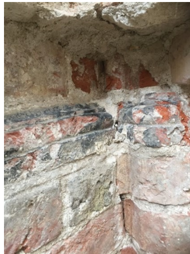
Fig. 14. Schakt A. Frilagd pelare i koromgången och detalj av svartglaserad formtegel. Foto: Anders Reisnert.
