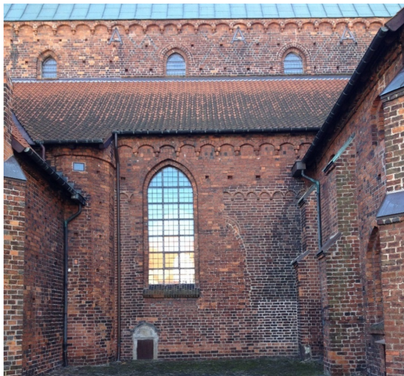
Fig. 5. Spor af frise og vindue fra 1200-tallet i murværket på nordsiden af Skt. Olai Kirke i Helsingør. Foto: Liv Appel, Museum Nordsjælland.
